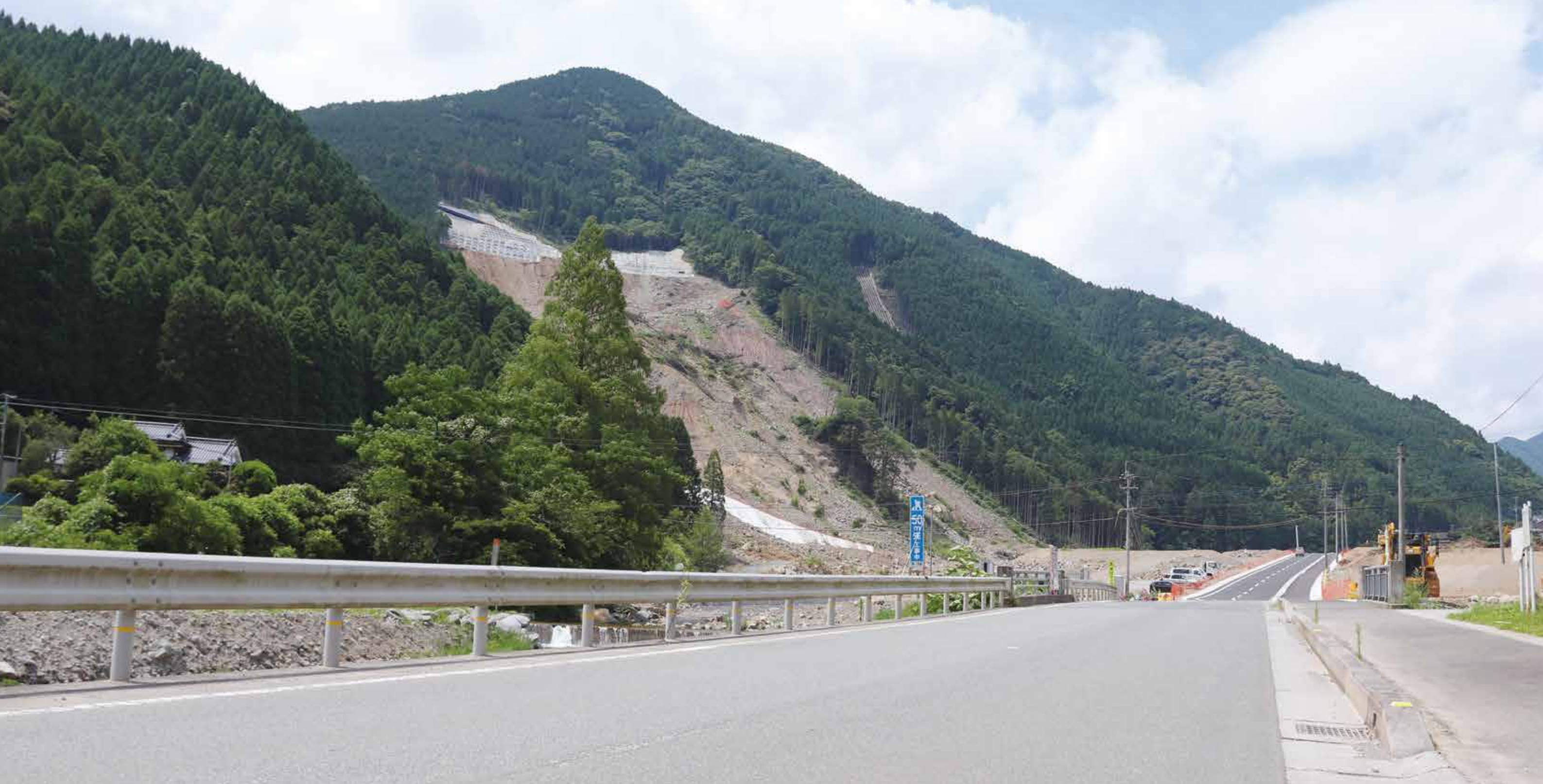
▲大規模な土砂崩れで被害を受けた小野地区の県道宝珠山日田線。令和元年6月28日午前8時に全面開通した。
