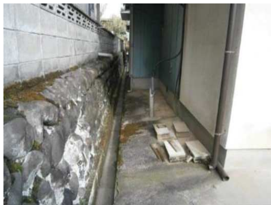
溝から右側が敷地
