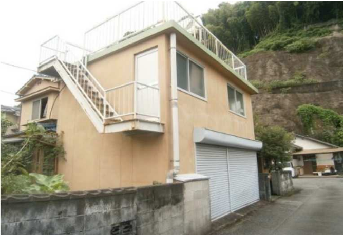
車庫物置 (屋上：太陽熱温水器)
