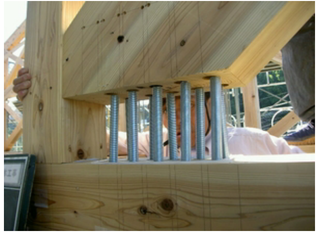
高瀬小体育館 拡張樹脂アンカー工法の接合部施工状況
