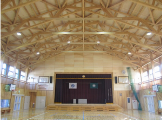
日田市立高瀬小学校体育館(木造)
