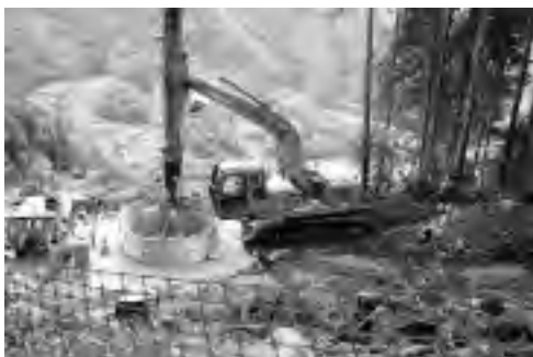
復旧が進む小野地区の現場
