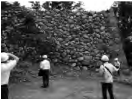
永山城跡石垣復旧工事現地調査
