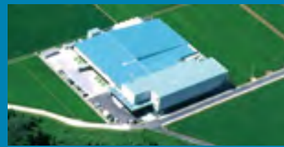
九州ジーシー 株式会社 日田工場 平成23年操業
