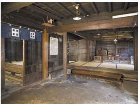
安永7(1778)年に建築された主屋の店舗部・帳場
