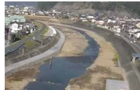
花月川（豆田地区の護岸整備）
