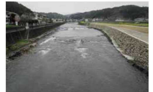
有田川（本村橋周辺の護岸整備）
