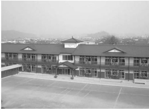
新築された咸宜小学校校舎 (資材には日田杉がふんだんに使われている)
