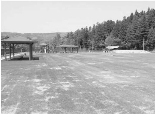
東有田地区のウッドコンビナート内に公園を整備 (ウッド平島公園：7月供用開始)
