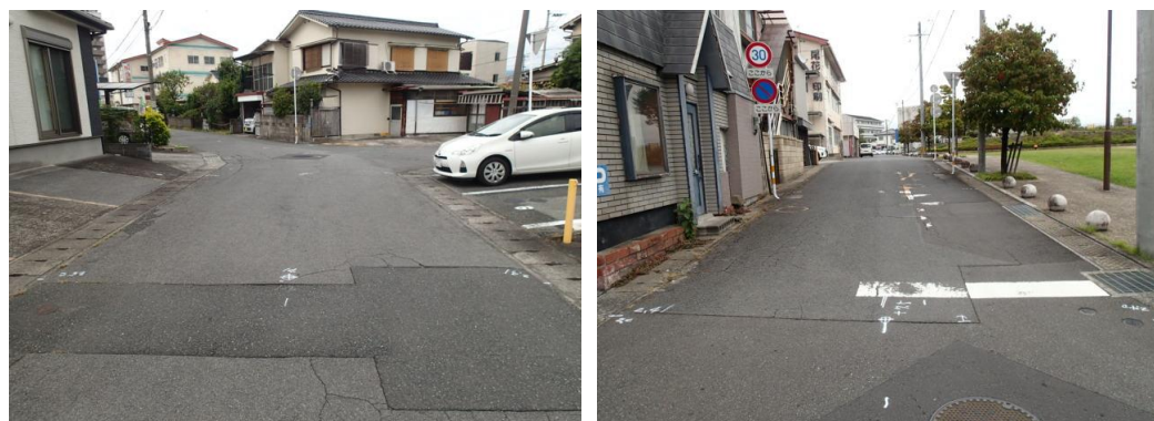
施工前の状況
