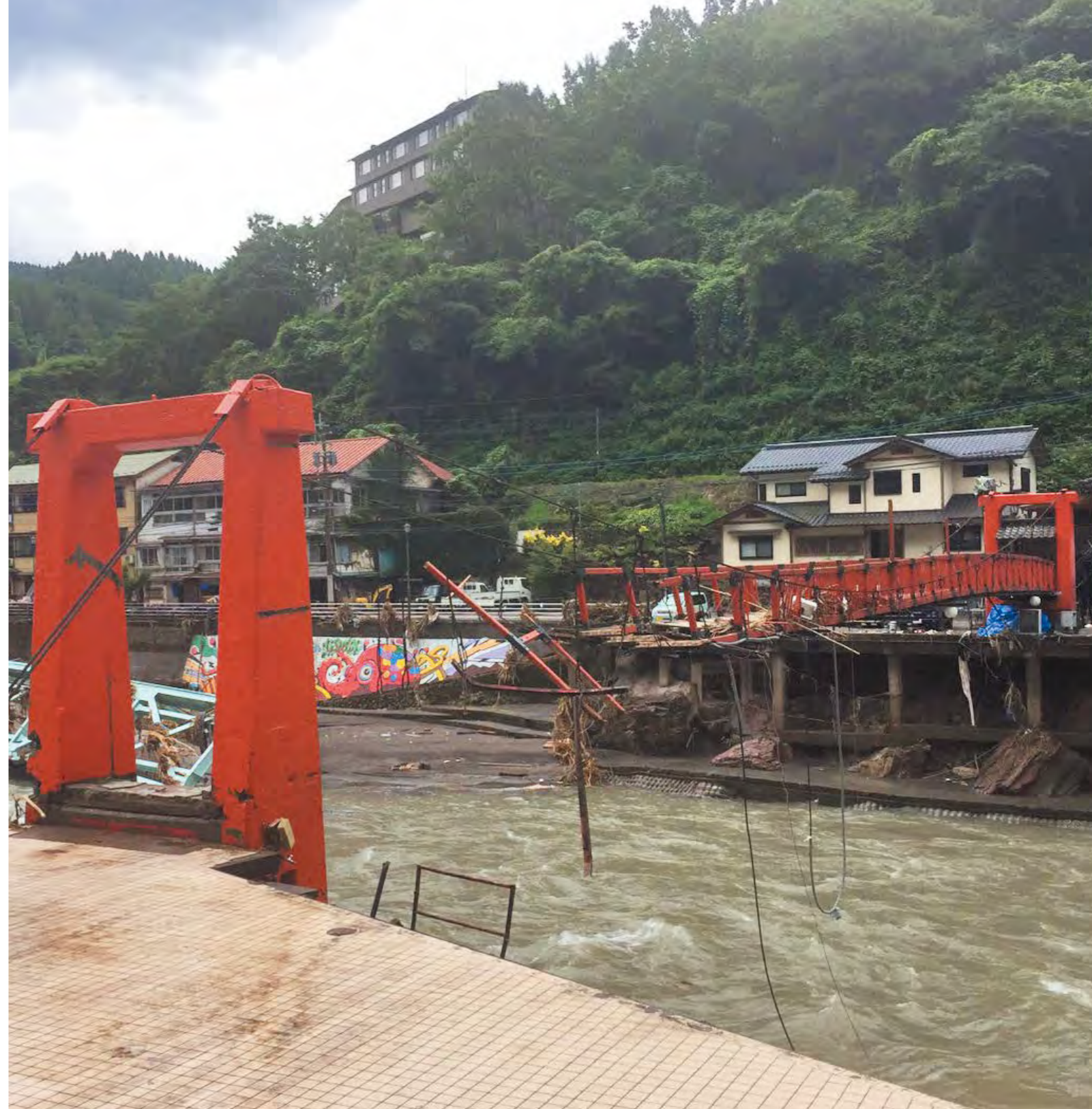
▲令和2年7月豪雨で被災した天瀬町
