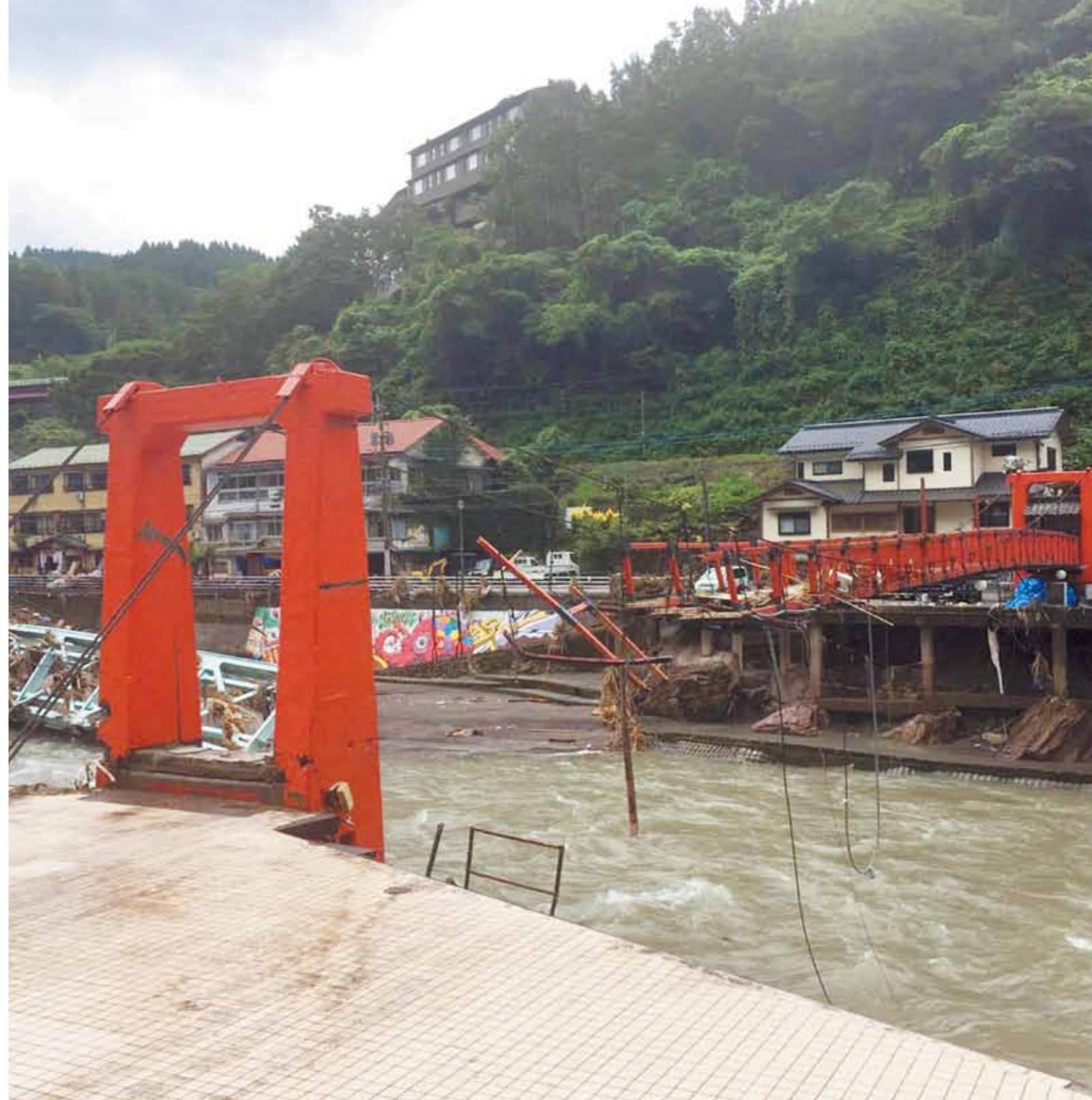
▲天瀬地区（猛烈な豪雨で一部が流失した成天閣の吊橋と崩落した新天瀬橋）
