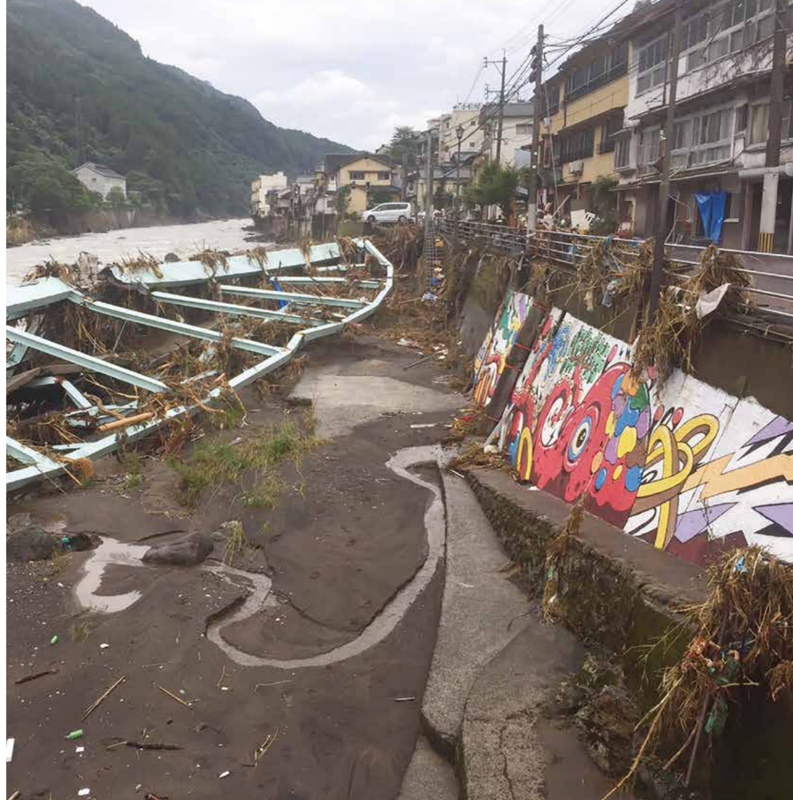
▲天瀬町（令和2年7月豪雨で崩落した新天瀬橋）
