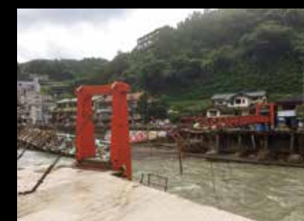
▲令和2年7月豪雨で被災した天瀬町
