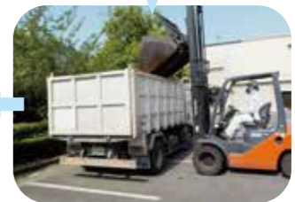
ダンプへ積み込み・金物選別
