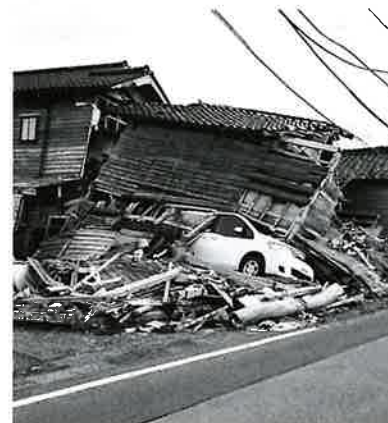
↑発災から5カ月以上経っても倒壊したままの建物
