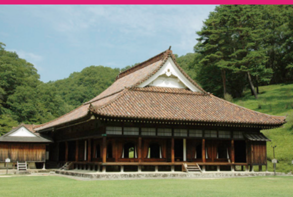
関谷学校(岡山県備前市)
