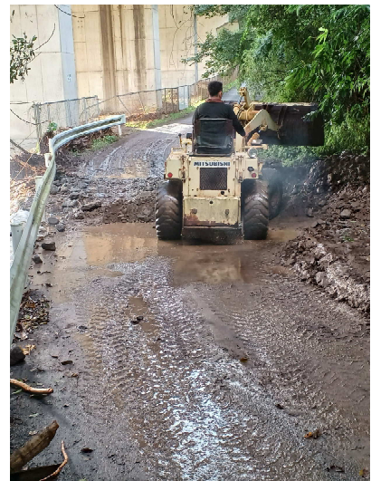
市道上の土砂を取り除いているところ
