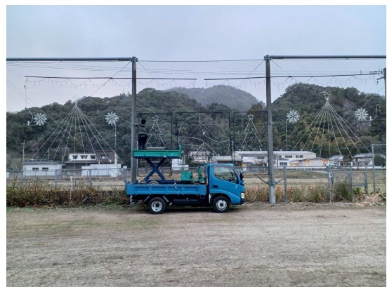
イルミネーションを設置しているところ
