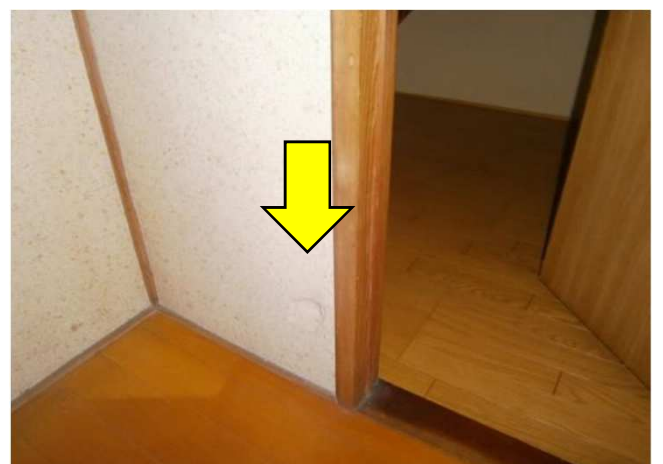
補修箇所：トイレの壁
