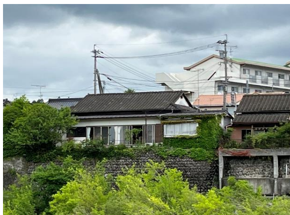
西側外観(対岸より)
