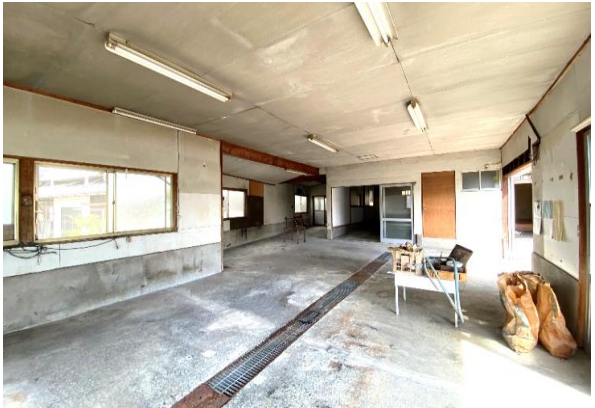
豆腐屋跡内部
