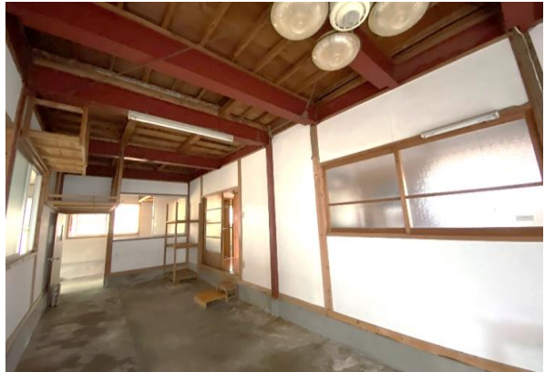
豆腐屋跡内部
