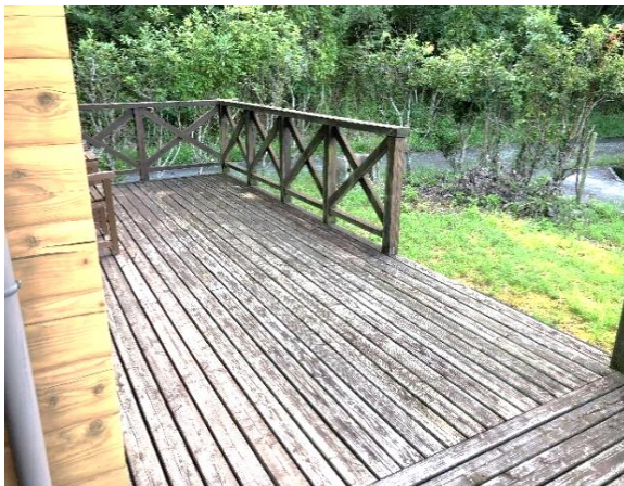
1階ウッドデッキ
