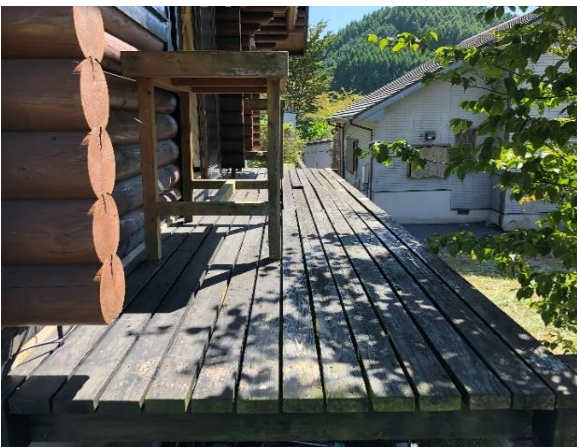
1階ウッドデッキ
