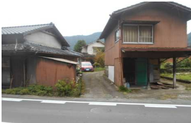
国道212号線からの進入路 (2m強)
