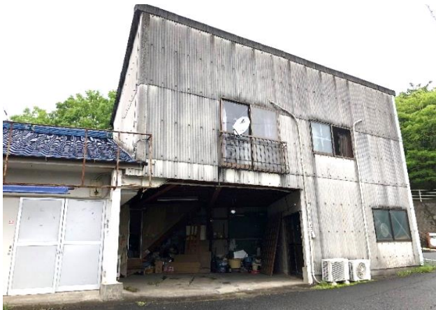
車庫・倉庫外観(鉄骨スレート)
