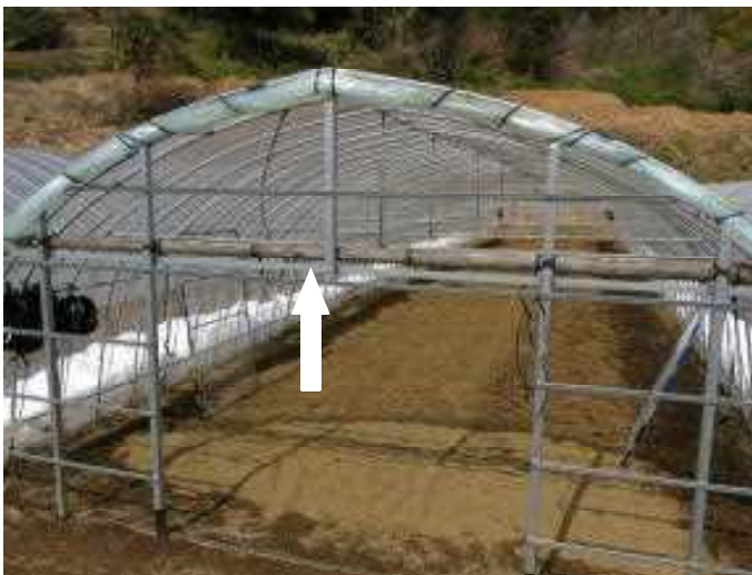
写真2 丸太により補強したハウス
