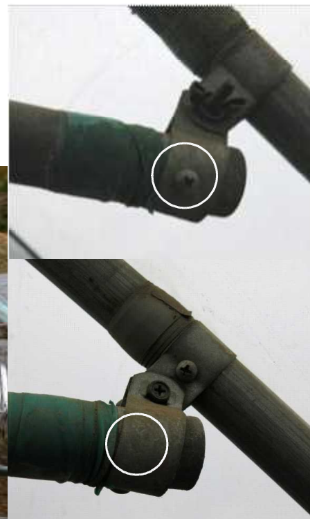
写真3 ボルトによる直管の補強
