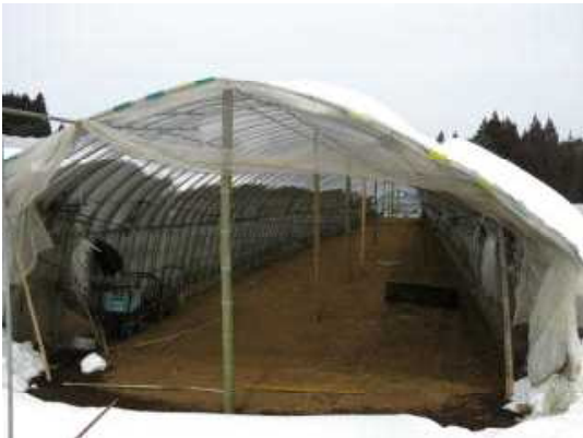
写真9 竹支柱により補強したハウス
