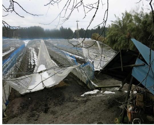
写真8 天井部に結びつけていたビニールの端に溜まり倒壊したハウスの端
