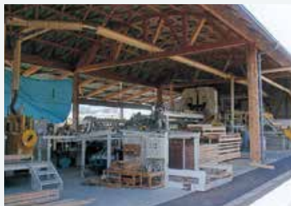
新設した製材ライン
