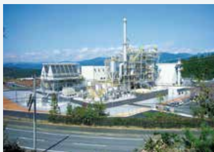
木質バイオマス発電所
