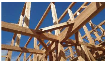
芯去り材を火打ち材として利用
