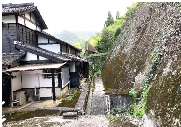
住宅裏面擁壁
