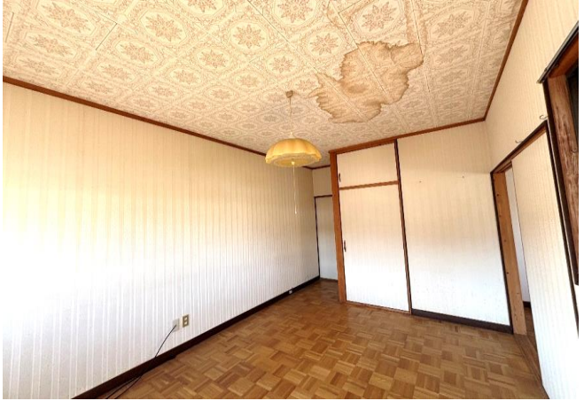
2F和室 天井雨漏り痕(補修済み)
