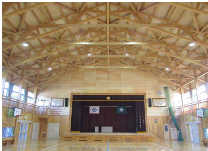
高瀬小学校屋内運動場（木造）
