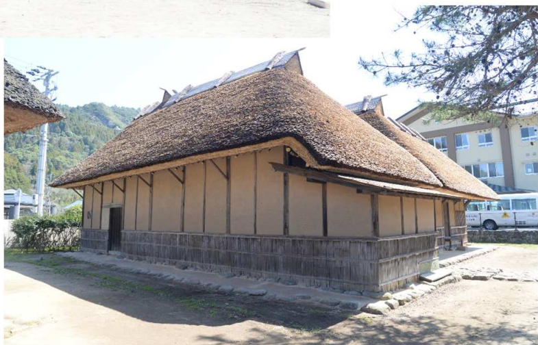
保存修理事業が完了した大山町の旧矢羽田家住宅
