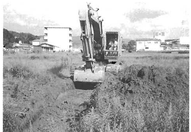
試掘調査状況
