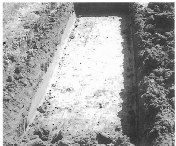
トレンチ完掘状況
