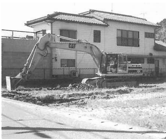
試掘調査状況
