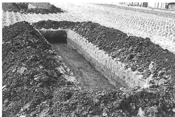
トレンチ完掘状況
