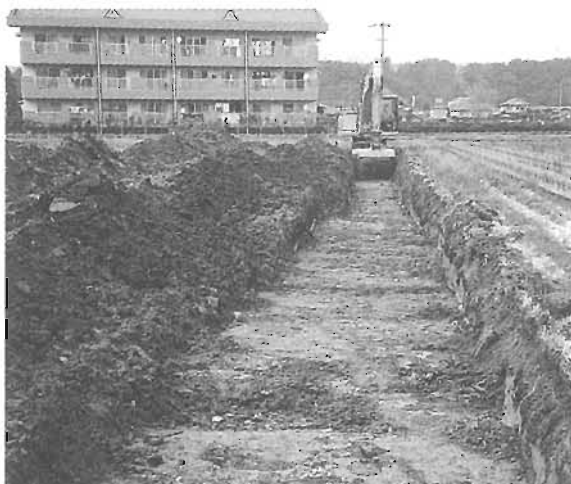
試掘調査状況
