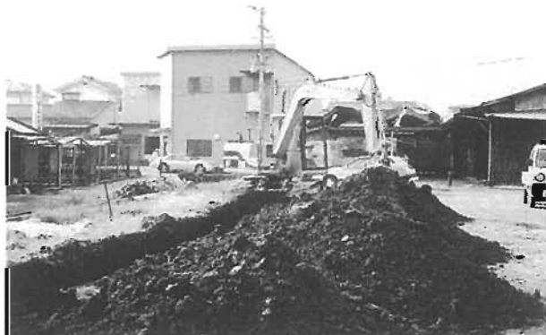
試掘調査状況
