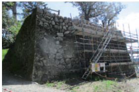
修理中の石垣
