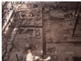
秋風庵解体修理時の基礎跡
