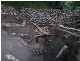
北側堀の石垣
