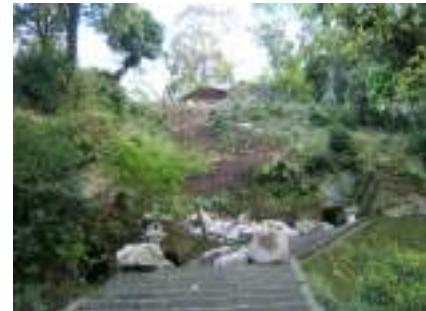
永山城跡の被災状況
