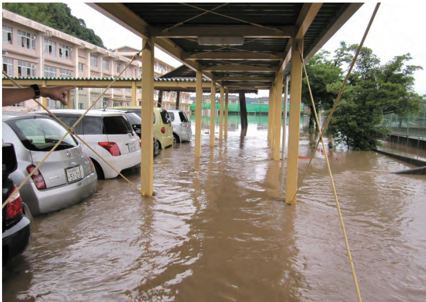
・冠水した光岡小学校の渡り廊下
