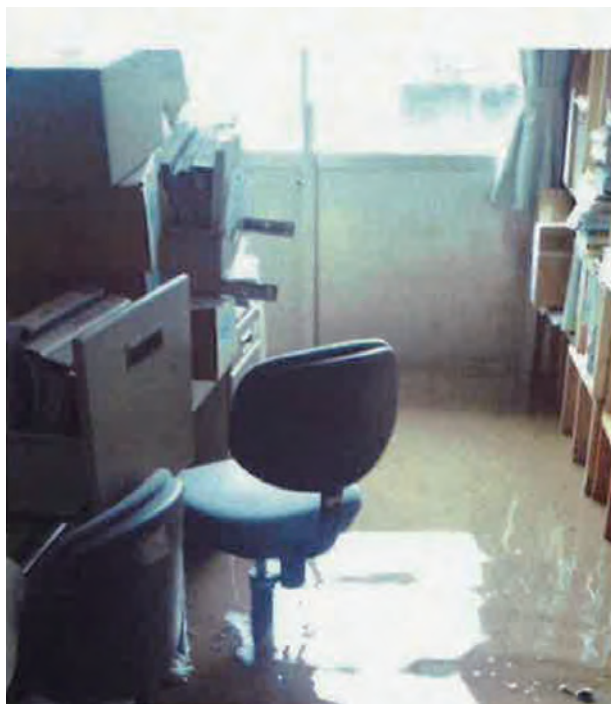
・冠水した北部中学校職員室
