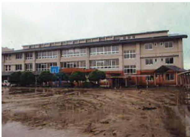
・洪水が治まった後の北部中学校玄関入口
