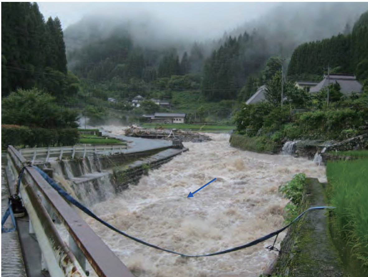
写真－2.6.5 串川の出水状況(串川橋より) 3)
