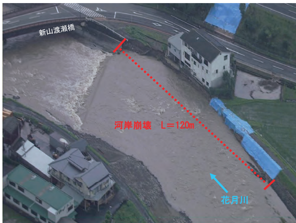
日田市西有田地区(花月川右岸 5K400付近) 河岸崩壊状況
