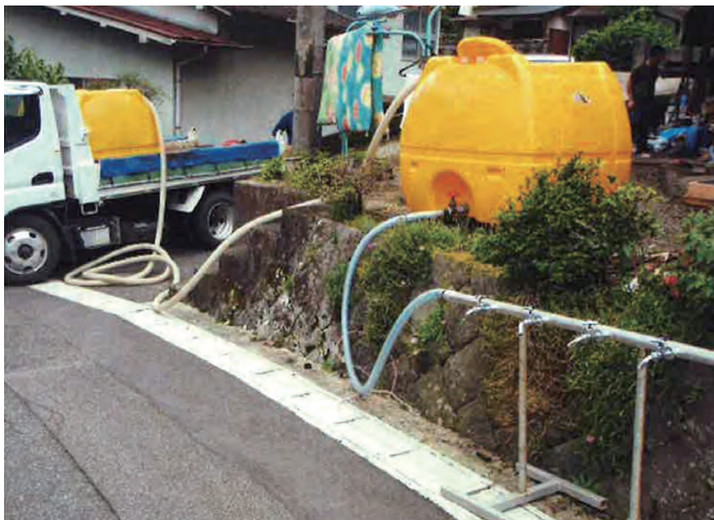
・前津江町志谷地区仮設給水所
