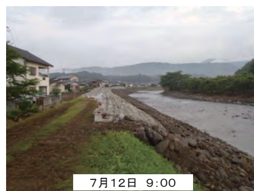
写真-2.4.5 被災した箇所の応急復旧工事(6K200) 2)
