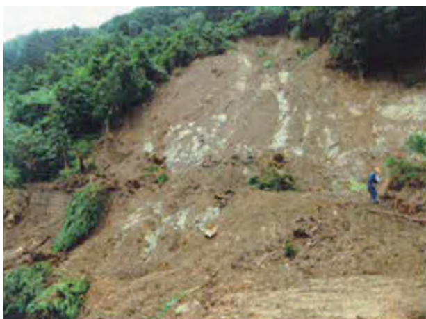
・前津江町（林道浦平線 起点0.6km付近）
