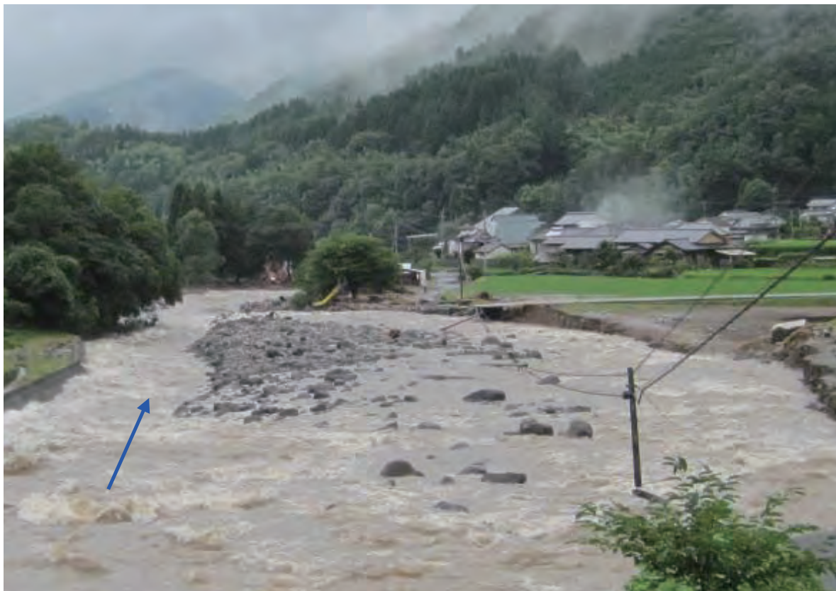
写真－2.6.7 花月川(大分県管理区間)の被災状況(秋原町) 3)
