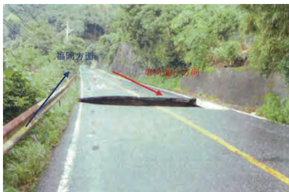
(夜明中町) ・日田市側から福岡方面を撮影した現場。
