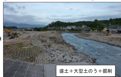
写真－2.4.10 花月川8K000付近の14日出水後の応急工事の状況 2)
