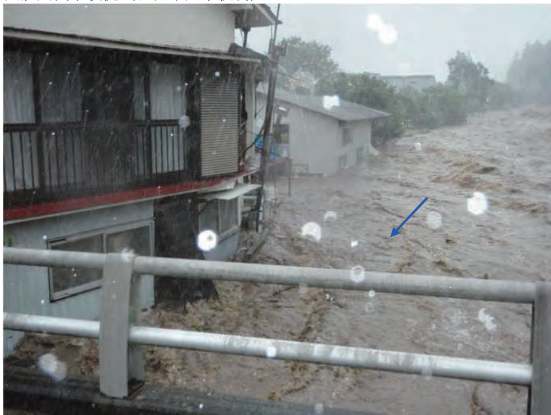
写真－2.3.3 大肥川沿いの人家への浸水(夜明橋より) 3)
