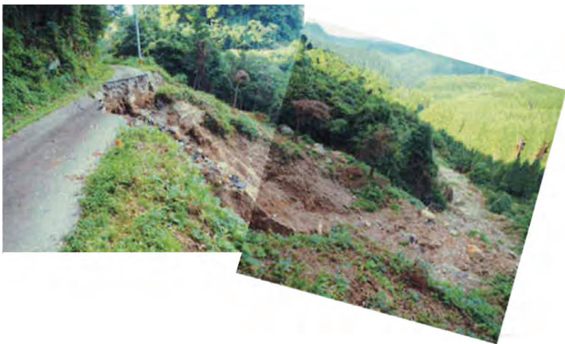
・大山町（林道竹ノ迫線 起点0.7km付近）
