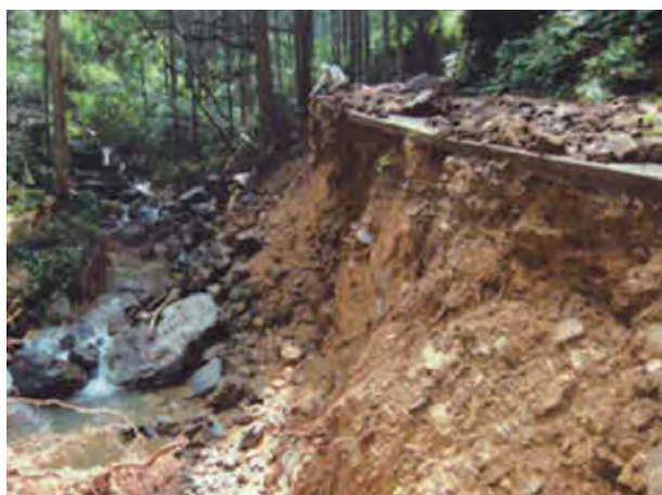
・同左（起点0.5km付近）
