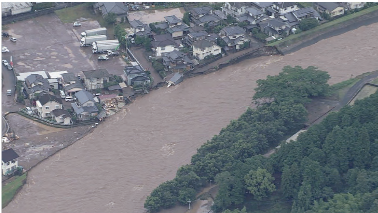
写真－2.1.2 花月川の堤防決壊状況(右岸・清水町)
