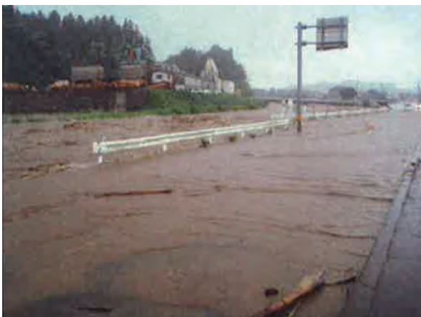
・県管理河川 有田川（上流から下流を見る）
