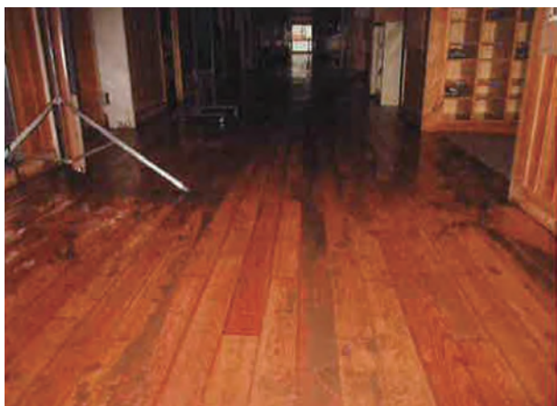
・清掃中の北部中学校1階廊下
