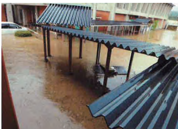
・冠水した北部中学校渡り廊下
