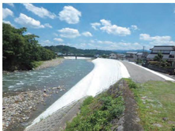
・平成25年7月13日本復旧工事完了後
