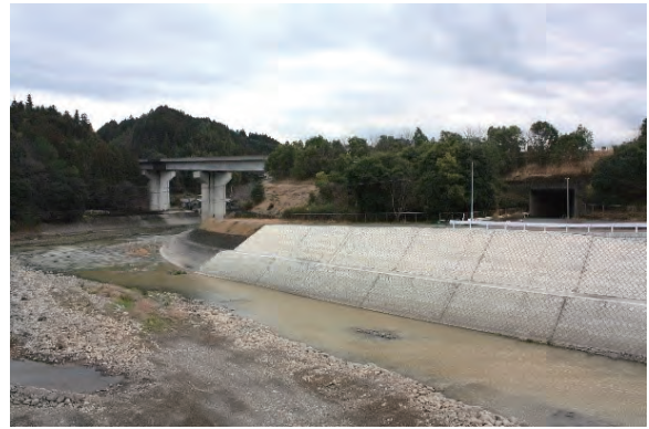
・新山渡瀬橋より下流を見る
