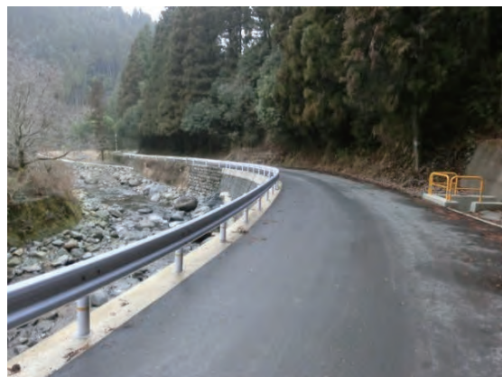
写真-5.1.1 日田土木事務所管内の復旧前後の写真
