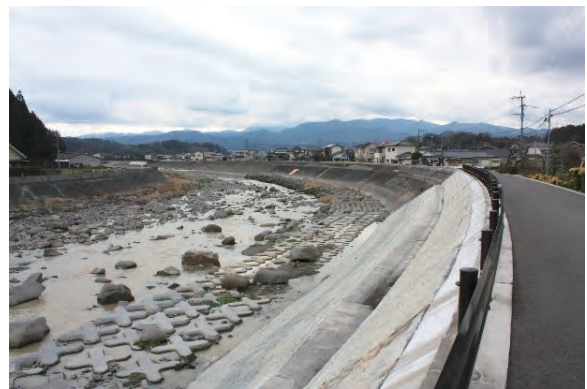
・髪永井堰下流付近(手前が右岸)
