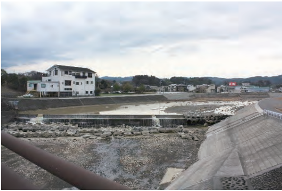
・新山渡瀬橋より上流を見る
