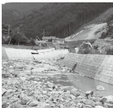
小野川の災害復旧現場
