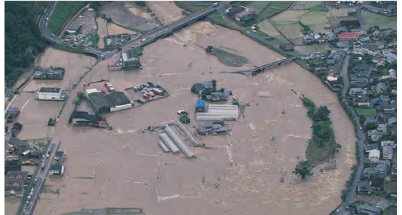
三花地区 花月川の堤防が決壊し、広範囲にわたって冠水した。 (7月3日 国土交通省撮影)
