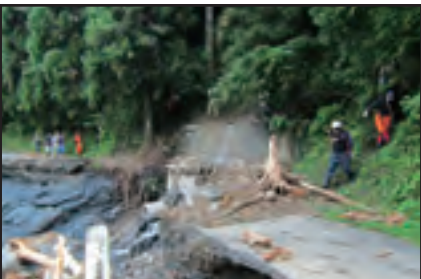
前津江地区 孤立した柚木地域。土砂崩れで道路が寸断された。
