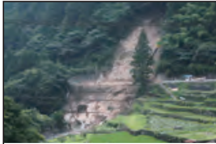
大鶴地区 大規模な土砂崩れが発生し、山が大きく削り取られた。
