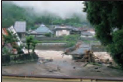
三花地区 濁流と流木などで倒壊した秋原町の家屋と橋。
