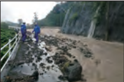
天瀬地区 山からの濁流で、道路はまるで川のように浸水してしまった。
