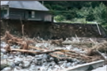
高瀬地区 上流から大量の土石流が流れ込み、川は流木や石で埋め尽くされた。
