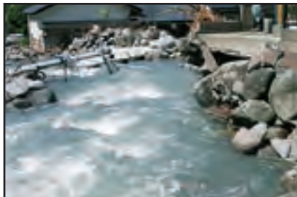
大山地区 吾々路川がはん濫し、岩石と濁流が押し寄せた民家。
