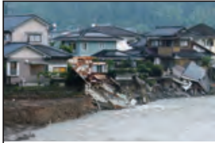
三花地区 花月川のはん濫により押し流された民家。
