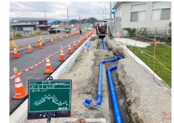
③ 水道管移設工事
