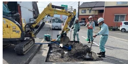
② 漏水したところの補修
