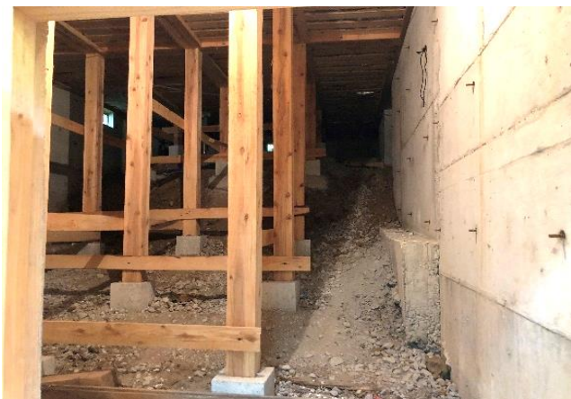
1階収納スペース
