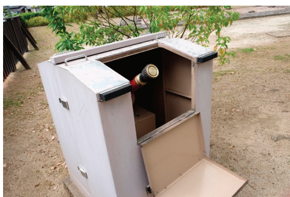
写真 4-5-6 設置した放水銃(咸宜園)
