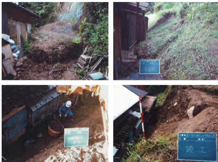
写真-4.3.1 住宅の土砂撤去状況
