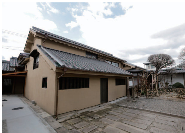
主屋完了 (2号蔵前)
