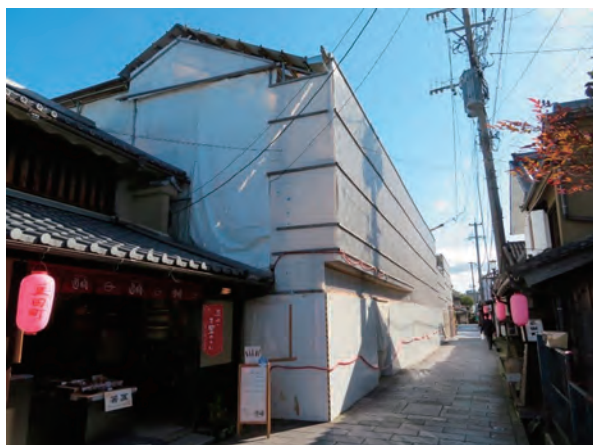
全景：仮設覆い屋
