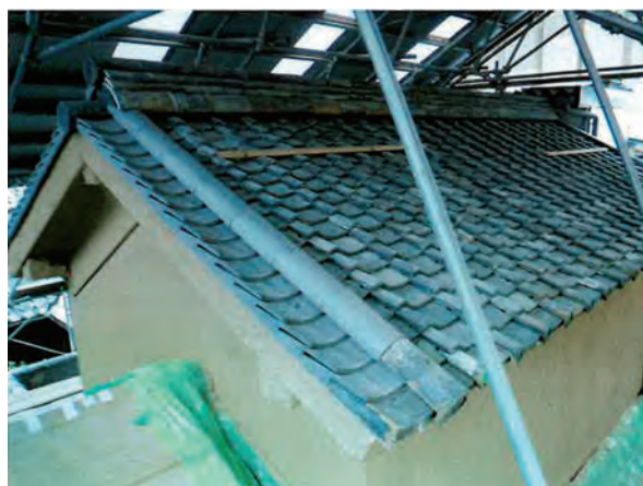
屋根工事（土居葺き完成）
