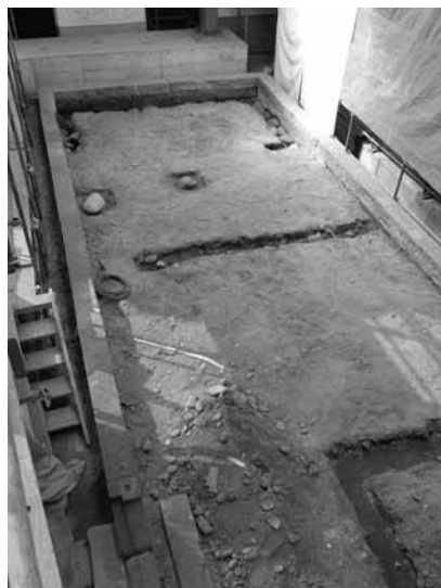
隠宅蔵基礎（南東より）
