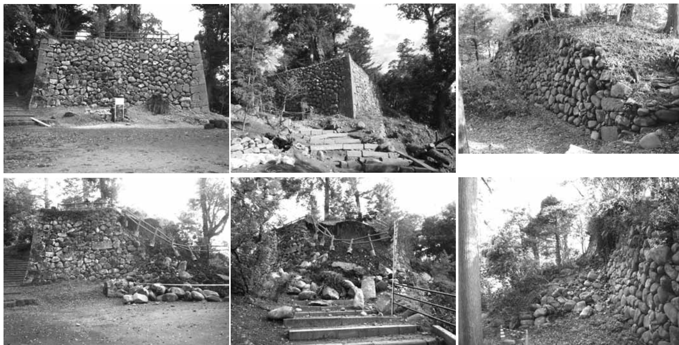
大手石垣西面 （上：崩落前 下：崩落後）
