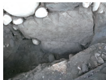
D区石垣南隅の算木・根切り地業検出状況
