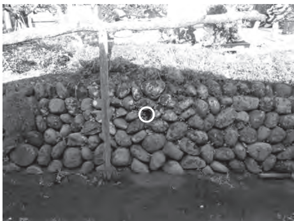
写真9 排水場所(白丸が土管)
