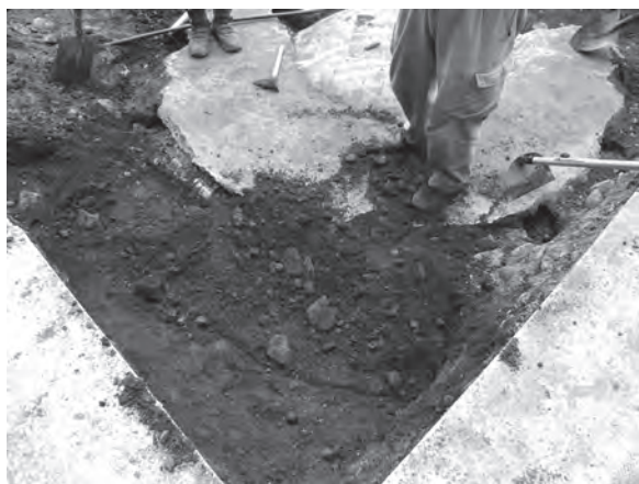
写真5 転車台跡の掘り込み面の確認
