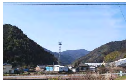
山間に立つアンテナ鉄塔
