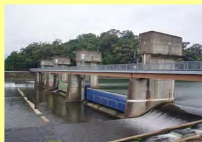
三隈川可動堰
