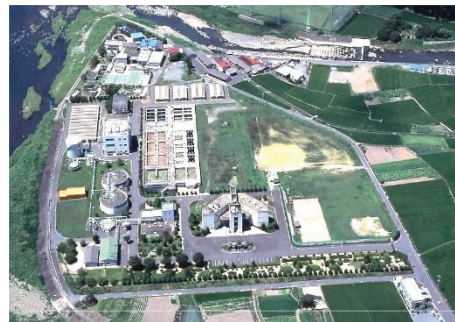
▲浄化センター
