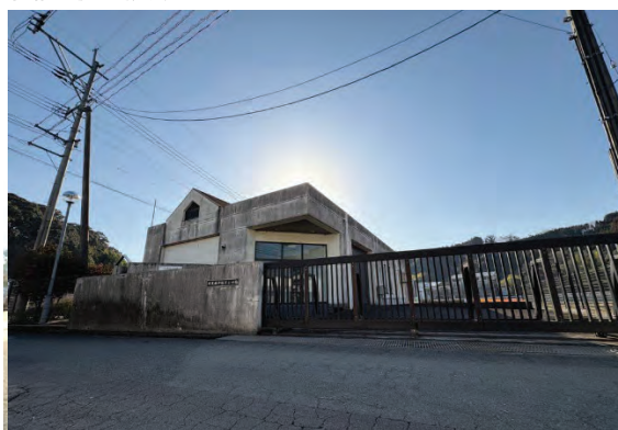
▲北友田中継ポンプ場
