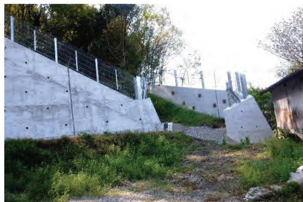
▲急傾斜地対策
