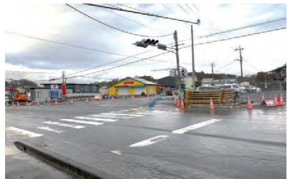
▲財津雨水幹線(工事状況)
