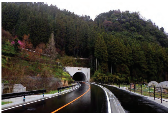
▲国道212号(ひびきトンネル)
