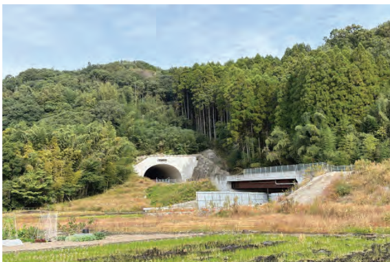
▲中津日田道路(5号トンネル)
